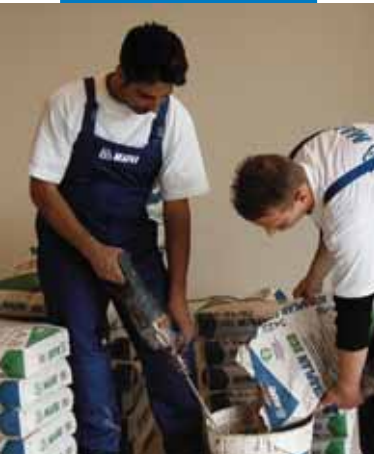
Prepararea Ultraplan Eco - Gradinita Mirabello - Cantu (Como) - Italia
